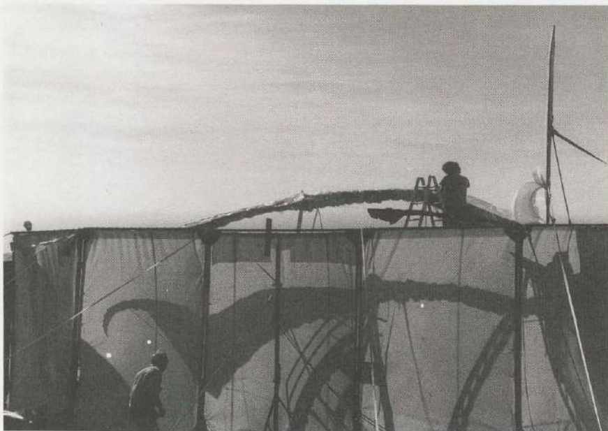
Ombres chinoises, à contre-jour du soleil, à Beaumont. La voilure est partiellement en place sur la structure de l'aile, tenue sur le bâti d'essais. L'ensemble est entouré d'un pare-vent en toile translucide. Le personnel, juché sur des échelles s'active au boutonnage.
