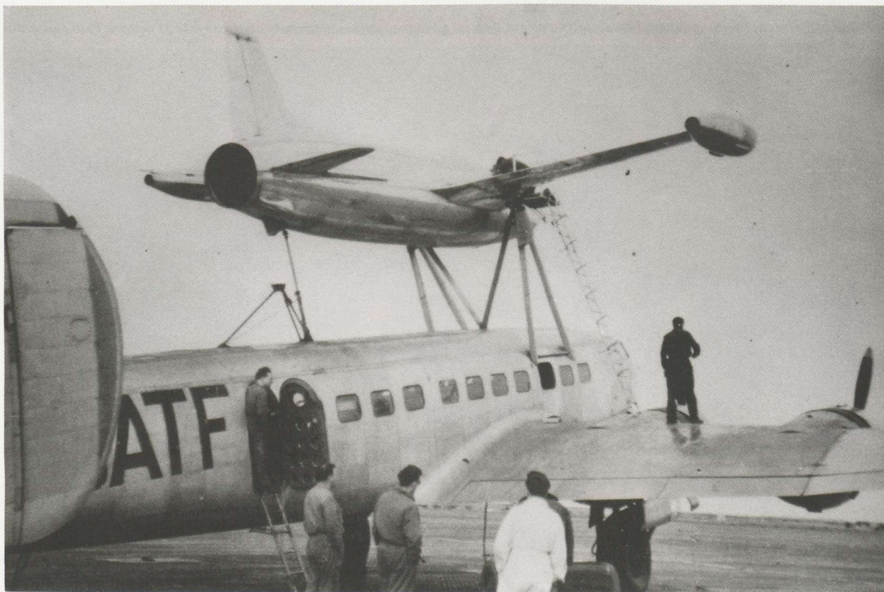
Le Leduc 016 avec ses Marboré I en bout d'ailes sur le dos du Languedoc n° 6 (F-BATF) (Photo Jacques Descroix).
