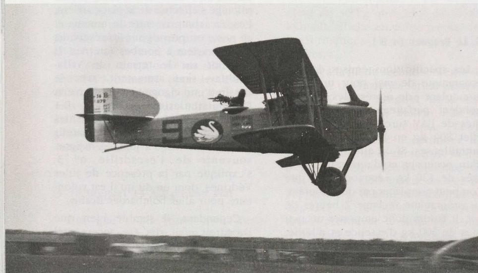
Photo Moreau 1729 : Breguet 14 B2 n° 1179 en service à l'escadrille BR 111, en survol de terrain à grande vitesse ; les volets automatiques sont effacés. Cette escadrille de bombardement dite « des cygnes » fut célèbre pour ses raids sur Sopwith, avant d'être transformée en octobre 1917 sur Breguet 14 B2. La « fenêtre » du bombardier est dans sa position définitive, sous le longeron supérieur du fuselage.
