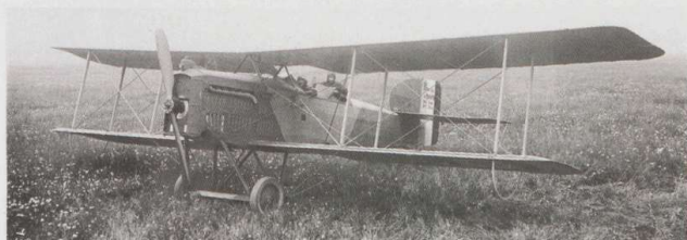
MSC 13850 : Un Breguet XIV à moteur Renault avec un compresseur Rateau. Remarquer que le tuyau d'échappement n'a plus la même forme.
